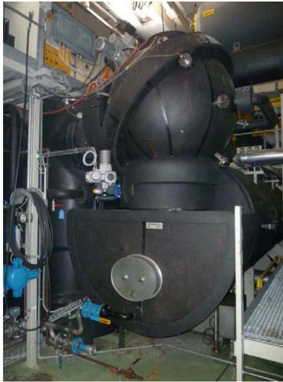
Abbildung 18: Kugelfilter oberhalb des Verdampfers
